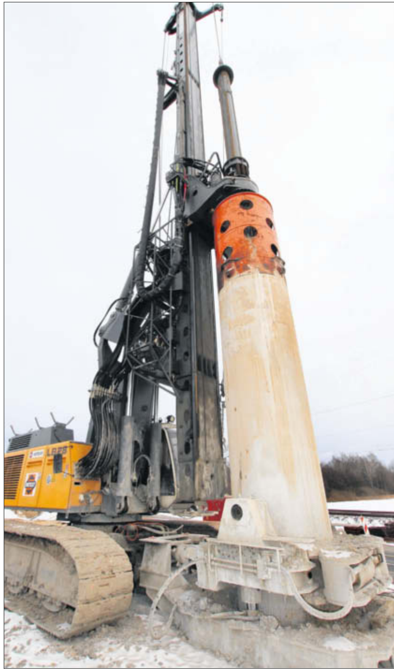
Schwere Bautechnik zwischen dem Kreisel Plüggenthin und Zirkow Hof nördlich Samtens. Hier wird tonnenweise Erde bewegt. Foto: Berndt
