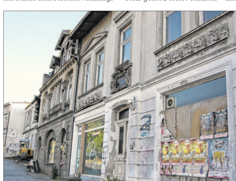
Ein Investor hat mehrere Grundstücke neben dem Steinmetzhaus in der Bahnhofstraße gekauft. Foto: ww
